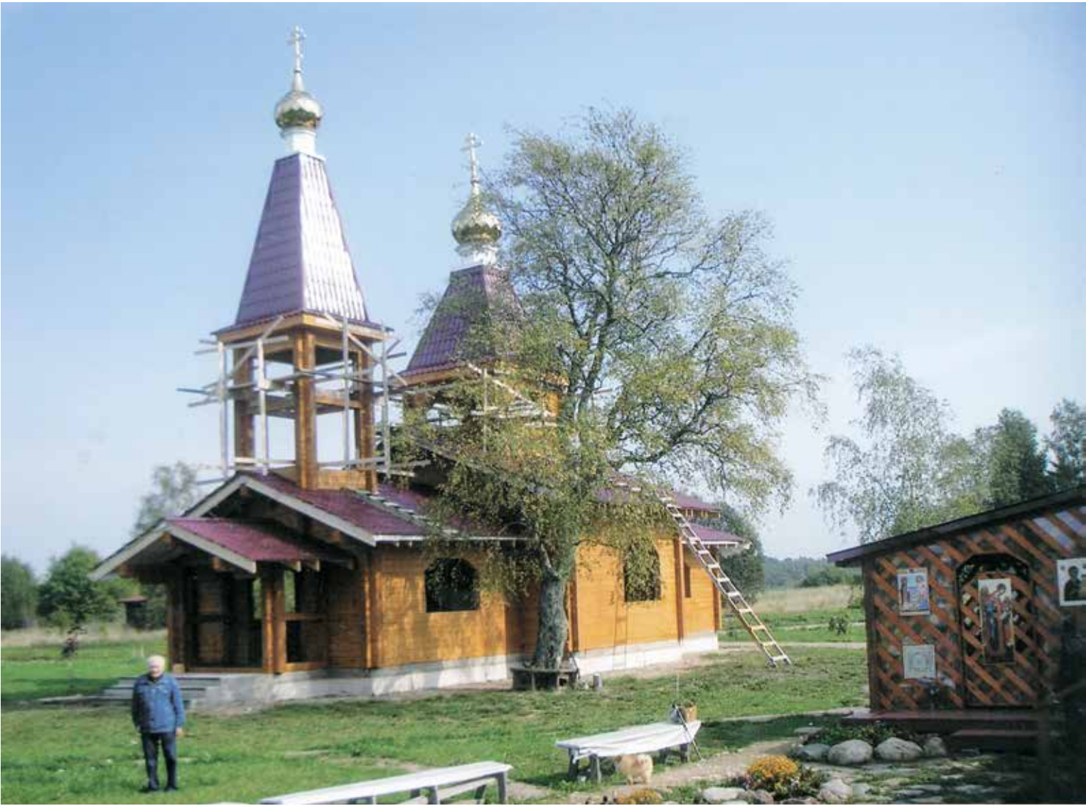
Viime kesänä Pyhän Nikolaoksen kirkko rakennettiin vesikattoon asti. KUVA: IVAN SAVIN
